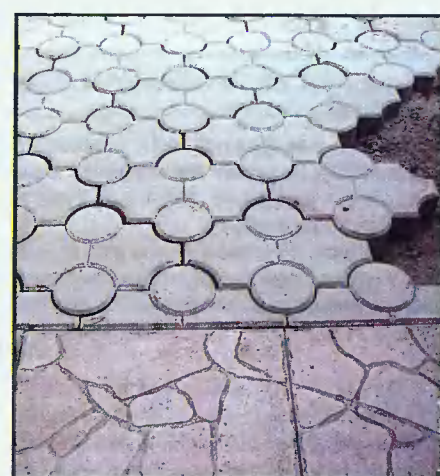
Поскольку площадка — с уклоном, швы получились не одинаковыми на уклонах, но с этим легко смириться
