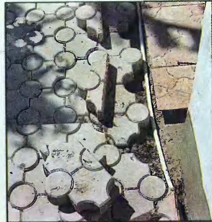
Чтобы потом при ремонте водопровода не вскрывать мостовую, сразу уложил новую трубу
