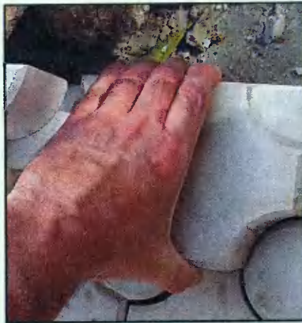
Для формирования края мостовой использовал специальные плитки из комплекта
