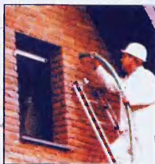
Здесь показана укладка утеплителя между основной и облицовочной кладками с помощью компрессорной установки. В качестве утеплителя используется вулканическая порода, больше известная под названием перлит
