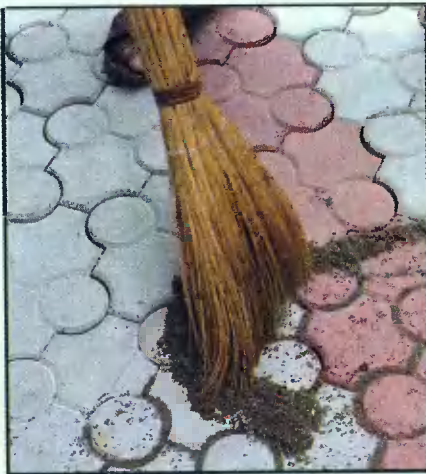
Заполнить швы сухой смесью можно обычным веником
