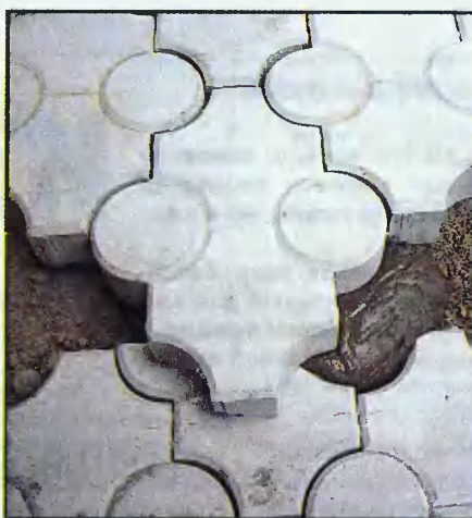
Там, где мостовая образует ступеньку, плитку лучше положить на раствор
