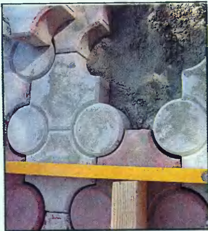
Плитку укладывал на сухую смесь, которая со временем превратится в монолит
