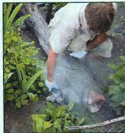
Для подрезки плитки на краях мостовой нужна «болгарка». Защитный кожух с нее пришлось снять, поэтому работать нужно было крайне осторожно
