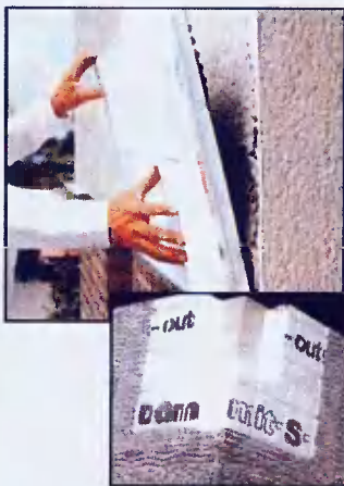
В качестве наружной теплоизоляции отлично зарекомендовали себя комбинированные системы «мокрого» типа на основе пенополистирольных или минерально-волоконистых плит, покрываемых паронепроницаемой штукатуркой со стеклотканью
